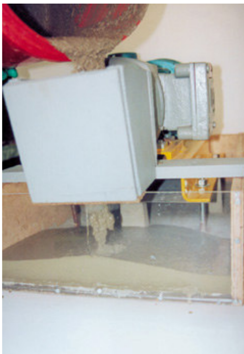
(6) Graute fluindo por baixo do equipamento
