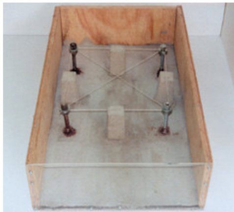
(2) Nivelamento dos calços (shims) de apoio do equipamento
