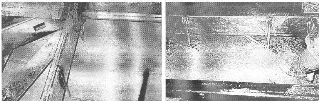
Figura 8 - Posicionamento e incorporação do enrijecimento metálico a painéis GRC (PCI, 1995).
